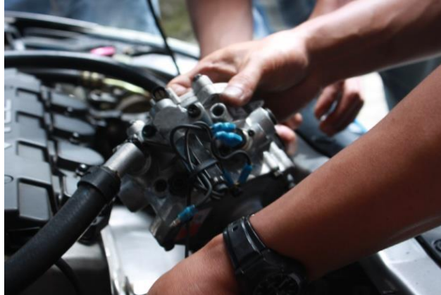
Gambar 10 Pemasangan vaporizer pada ruang mesin
